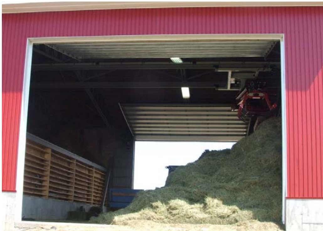
Figure 6. Entreposage temporaire du foin avant le chargement dans les cellules de séchage (source : MAPAQ)
